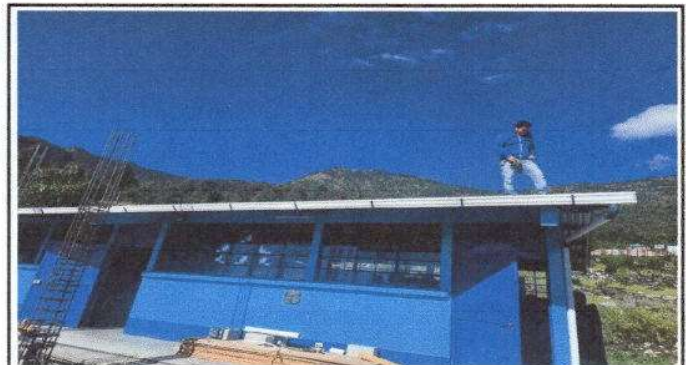
Foto 4: Implementación de bajadas de agua pluvial en aulas y cocina
