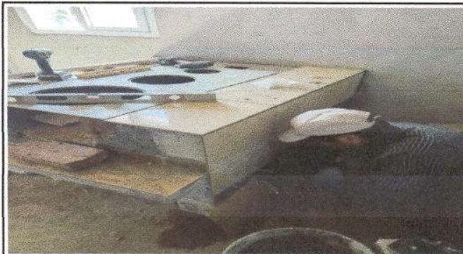
Foto 9: Sustitución de estufa rural completa incluye chimenea y plancha de metal.
