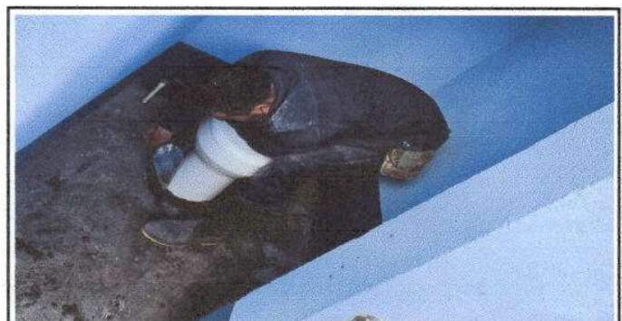
Foto 6: Sustitución de inodoros en servicios sanitarios por baños lavables
