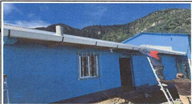
Foto 3: Implementación de canales en aulas y cocina para evitar goteras
