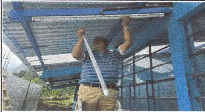
Foto 7: Sustitución de lámparas en aulas y corredor para mejorar la iluminación
