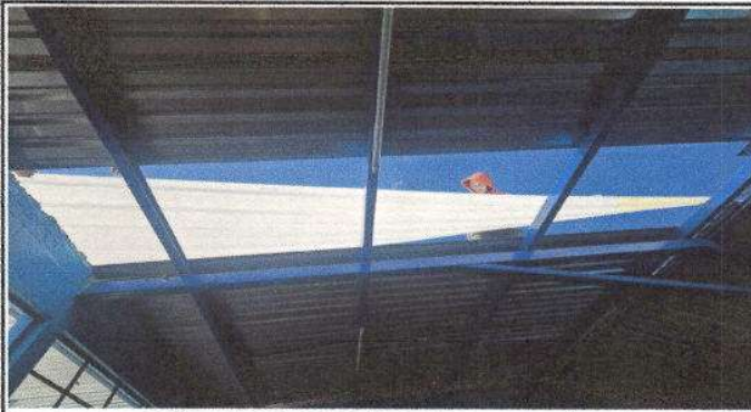
Foto 1: Sustitución de lámina troquelada Aluzinc calibre 26 por lamina de policarbonato troquelada Aluzinc calibre 26.
